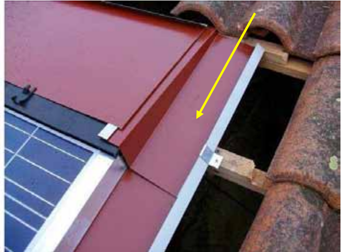
Abergement latéral (pièce n°4)
