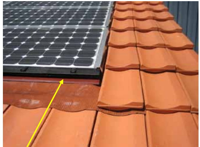
Abergements bas : pièces n°5 (quantité égale aux pièces n°3)
