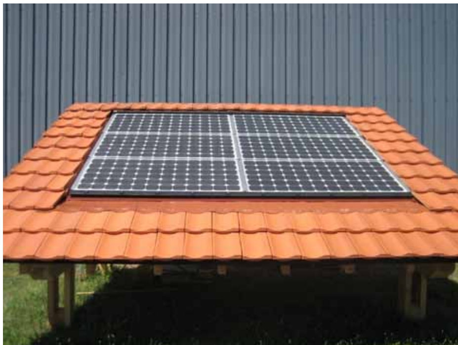
Aspect du kit complet une fois posé : les abergements sont masqués par les tuiles.
