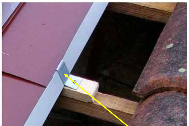
Détail crochets (pièce n°6)
