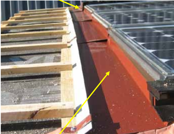
Abergements latéraux : pièces n°4 (la quantité dépend du nombre de lignes)
