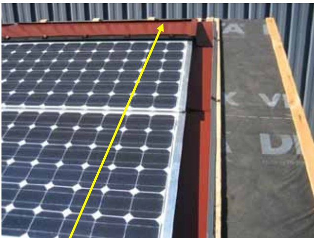
Abergements hauts : pièces n°3 (la quantité dépend du nombre de colonnes)
